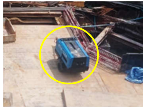
ภาพที่ 2.2-14 การปิดครอบเครื่องยนต์
