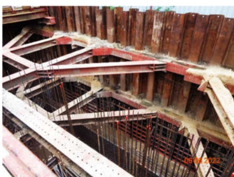
ภาพที่ 2.2-9 การติดตั้งระบบค้ำยัน
