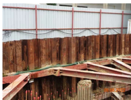
ภาพที่ 2.2-10 การติดตั้ง Sheet pile
